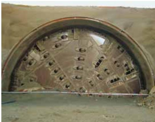
*Izquierda, la tuneladora en el momento del cale de uno de los tubos. Debajo, boca de uno de los túneles construidos en el trayecto Córdoba-Málaga.*
