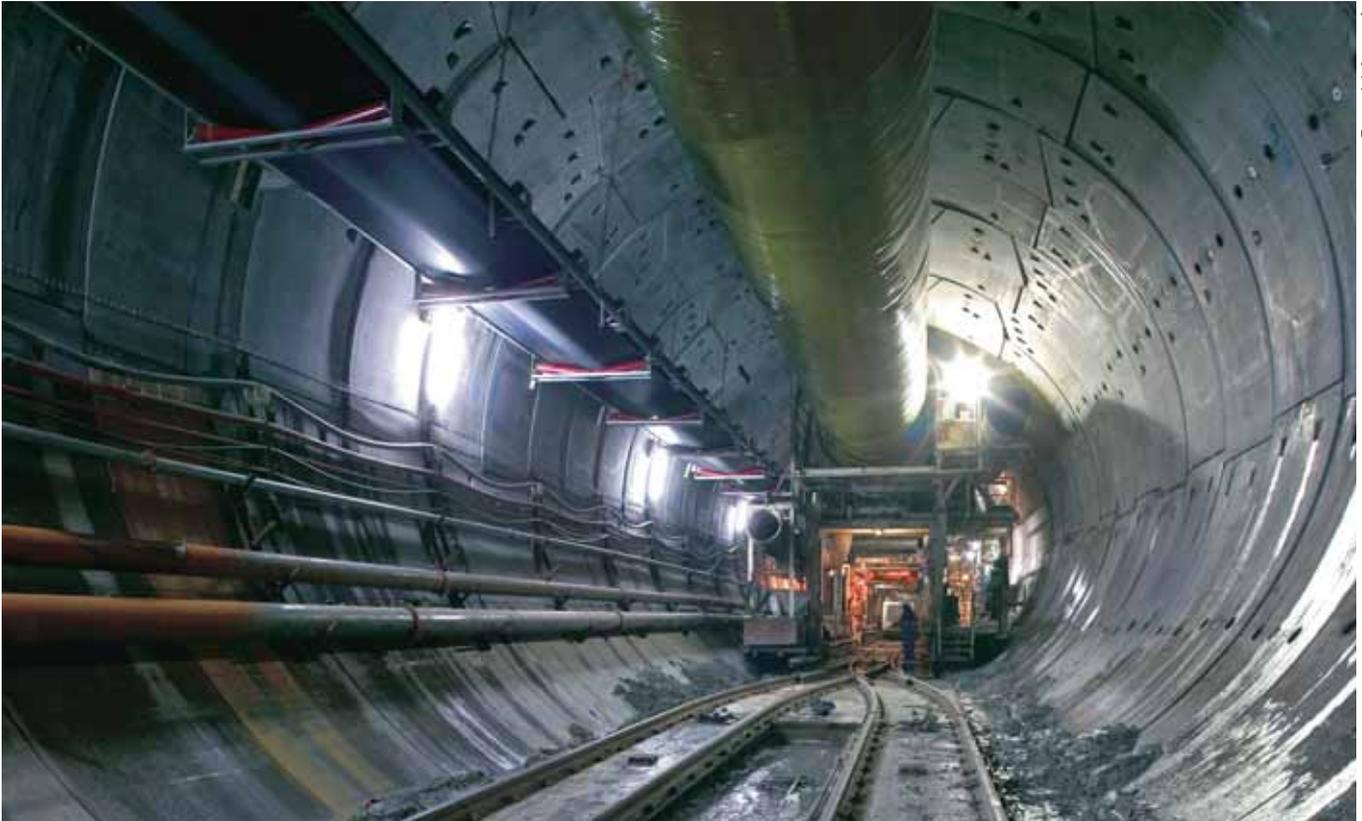
miento un total de 229.047 dovelas de hormigón armado procedentes de las cuatro fábricas que han alimentado la obra. Este cable permitió iniciar la nueva fase de obra civil en el tubo Este, antes de dar paso a los trabajos de superestructura, electrificación e instalaciones de seguridad y comunicaciones, proceso análogo al que se realizará luego en el tubo Oeste.
