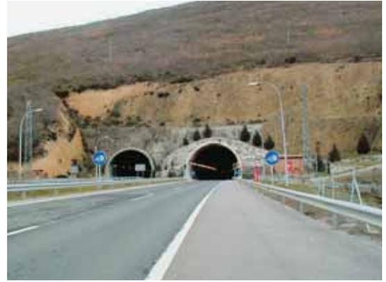
septiembre del año 2000 y finalizó en mayo de 2001. Entre otras actuaciones, se ha acondicionado un sistema de recogida de vertidos y el drenaje general del túnel, al tiempo que se construyeron galerías de evacuación y comunicación entre túneles.
