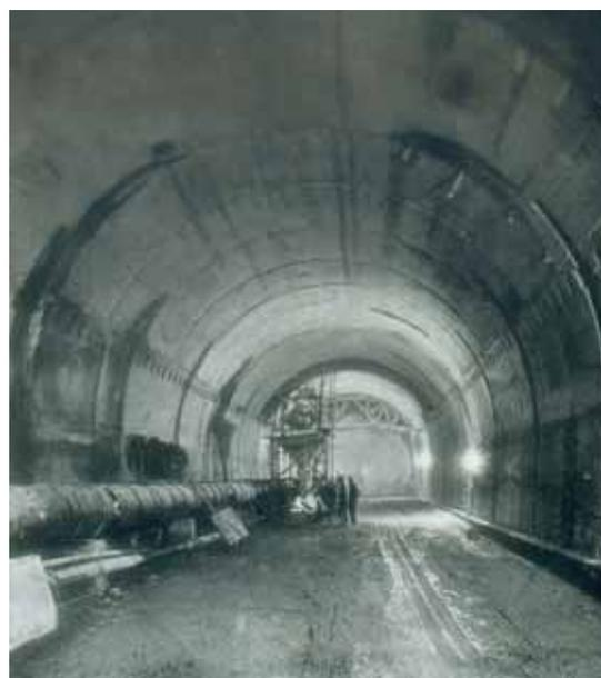
miento se efectuaba en camión, lo que permitía trabajar en cuatro niveles, con un total de 25 martillos ligeros Geiss. Acabada la perforación, se cargaba con dinamita, se colocaban los detonadores eléctricos y se efectuaba la explosión. A continuación se efectuaba la limpieza de las paredes y el bulonaje, y se retiraban los escombros con dos palas excavadoras, una en cada boca, y camiones.
