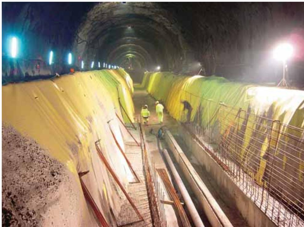
*El túnel de Vielha se ejecutó siguiendo el sistema del nuevo método austriaco.*
