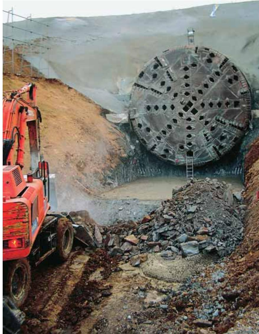
La tuneladora 'La Alcazaba' asoma por la boca norte de los túneles de Abdalajís. Izquierda, otra vista de una de las bocas.
