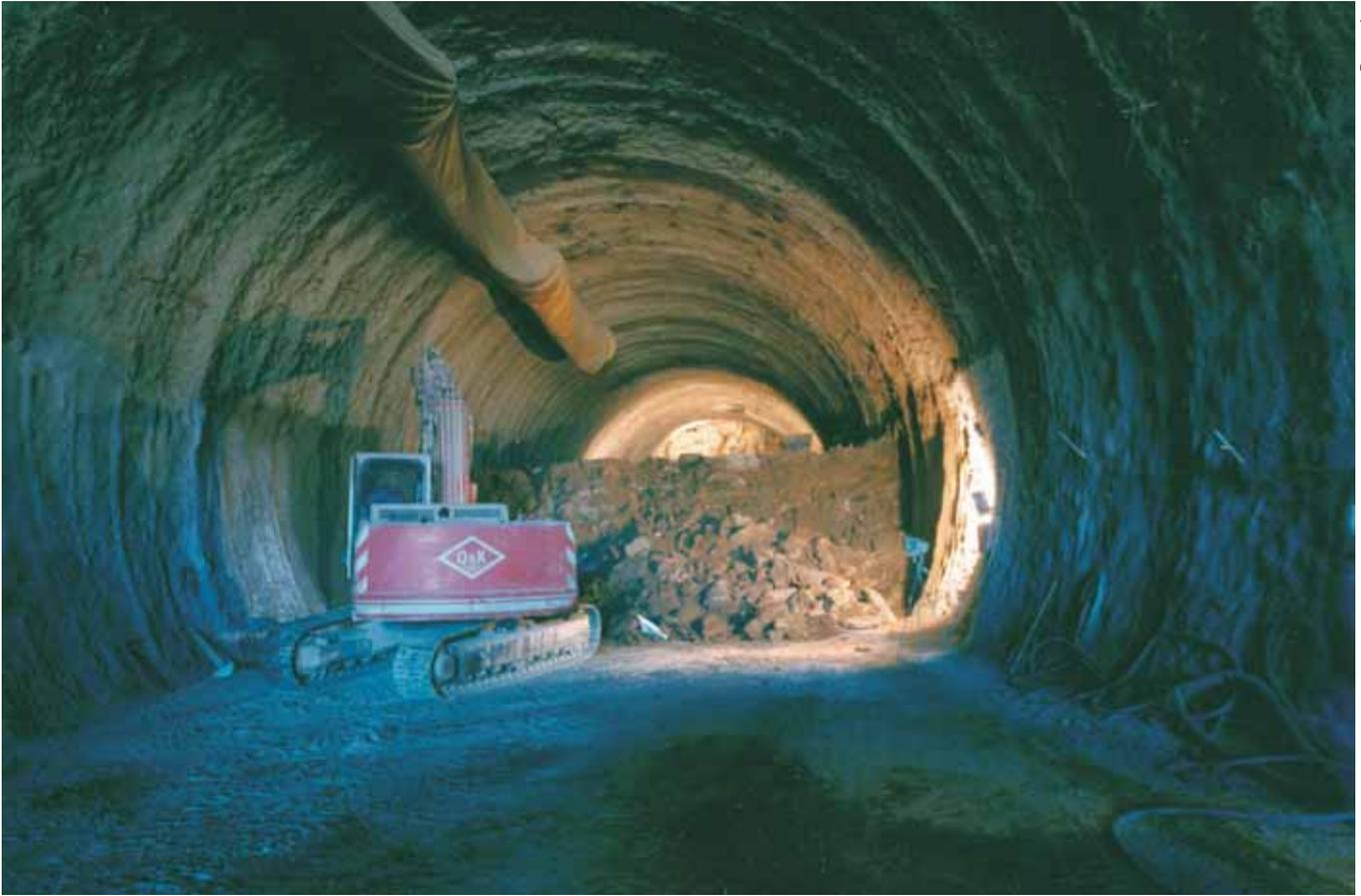
una calzada de 9 metros con dos carriles de 3,5 metros y arcenes de 1,50 y 0,50 metros. El espesor de revestimiento oscila entre 0,3 metros y 1 metro en algunos casos. La sección útil de los túneles de Pando es de 81,6 metros cuadrados, la pendiente es un 1,72% ascendente en el primero de los túneles y descendente al 1,66 % para el segundo.
