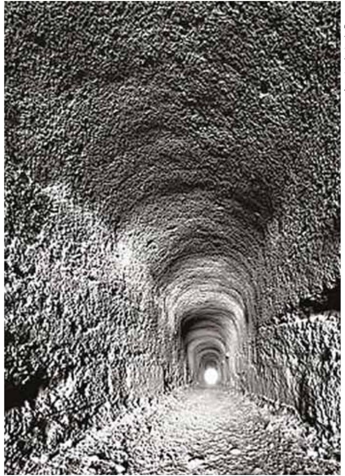
do las lluvias eran fuertes. La finalidad del túnel era en desviar las aguas directamente hacia el río Jiloca, evitando los graves perjuicios que las riadas provocaban a la población.
