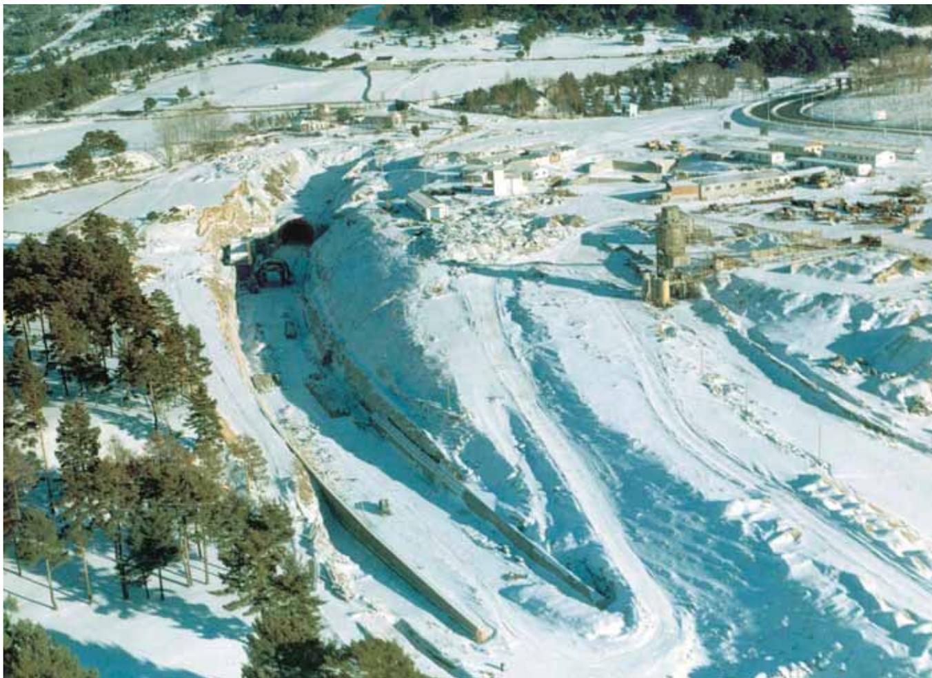
ras de 0,5 metros, y una altura libre de 4,50 metros. La boca sur, situada a una altitud de 1.195 metros, y la norte, a 1.285, presentan un desnivel de 90 metros. Los accesos a cielo abierto tenían en ambas bocas una longitud aproximada de 1.300 metros, con un ancho de calzada de 7 metros y dos arcones de 3 metros. En el acceso norte, próximo a la entrada del túnel, se encontraban situadas las casetas de peaje.
