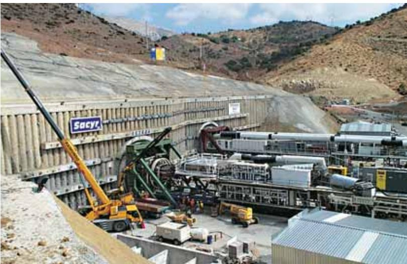
*Tuneladoras atacando las bocas de los túneles. Derecha, uno de los tubos de Abdalajís ya en estado de operatividad.*
