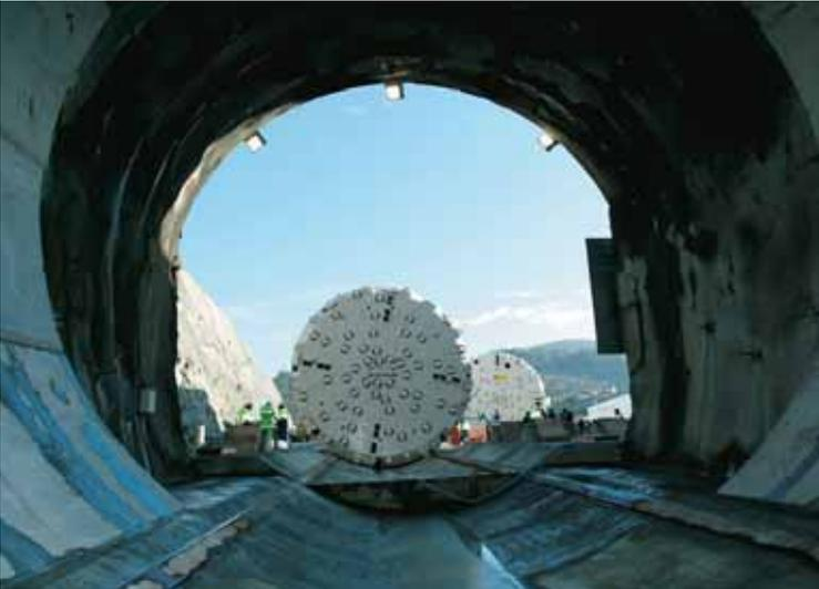
Dos imágenes de las tuneladoras ante las bocas de los túneles.
