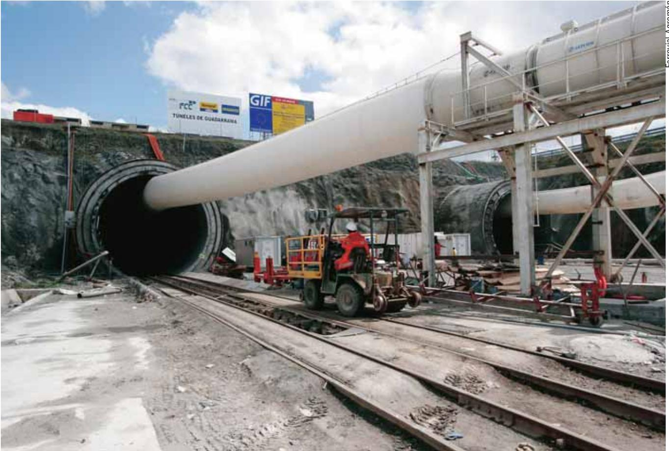
En el tubo Oeste, una vez extraída la tuneladora atrapada, continuó la excavación por métodos convencionales desde la boca norte y desde la galería intermedia, produciéndose el encuentro entre ambas en enero de 2007. Al mismo tiempo, los trabajos de revestimiento y de instalación de infraestructura ferroviaria en ambos tubos se desarrollaban en las zonas ya excavadas.
