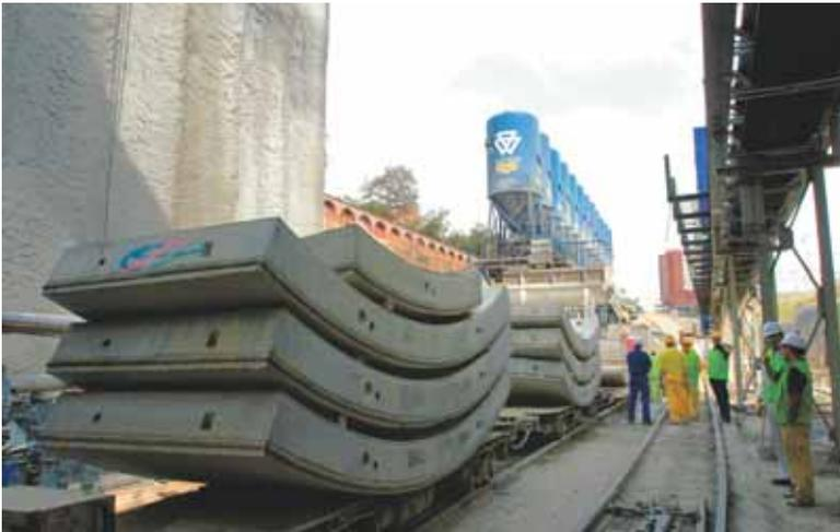
*Dovelas de hormigón para revestimiento del túnel en la boca norte del túnel.*
