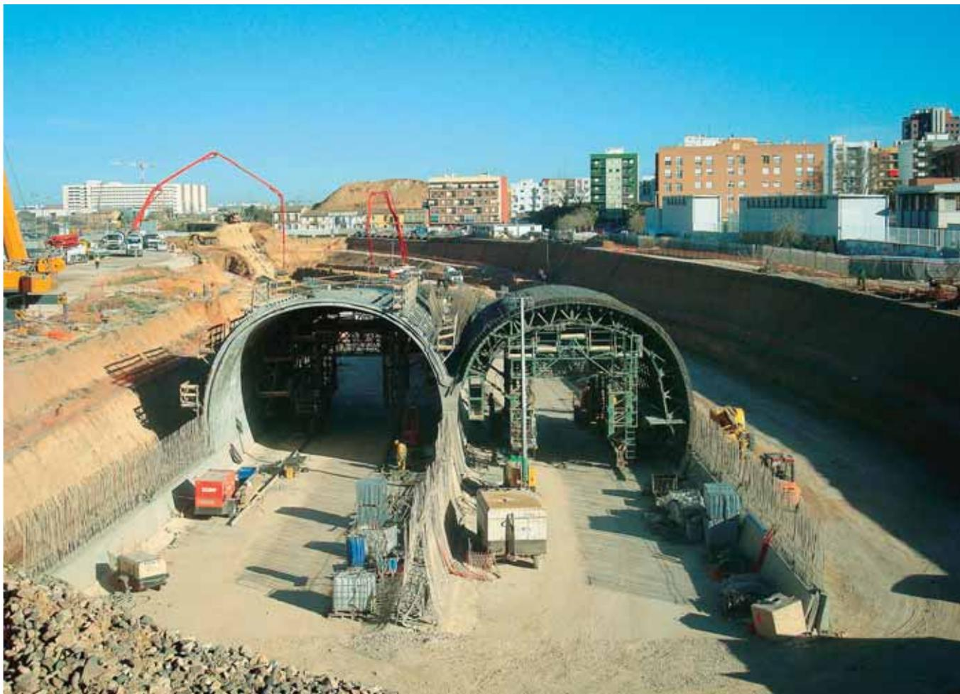
más largo de España. Este falso túnel atraviesa el barranco de Torrent y discurre bajo la carretera entre Torrent y Alaquás, que tuvo que cortarse para su ejecución. Se ha construido primero mediante la ejecución de una profunda trinchera y luego colocando la bóveda y la contrabóveda (suelo), por medio del procedimiento de bóveda ejecutada in situ. El falso túnel tiene una altura de 9,2 metros y una sección de 110 m<sup>2</sup>.
